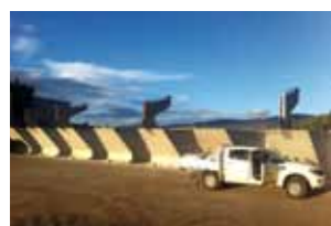
AUSTRALIA | Quipolly dam
